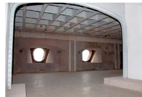
Внутренний вид бруствера Шведе до реставрации (слева) и после
