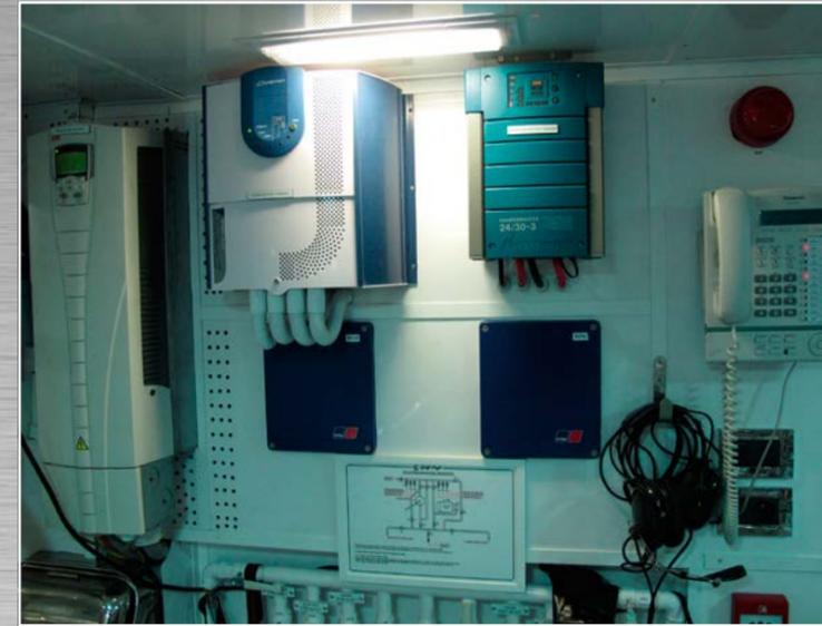
менили данное свойство в своей продукции, значительно снизив массу трансформатора. Использование высокочастотного преобразования снизило и пульсацию выходного тока, которая негативно сказывается на сроке службы батареи.
