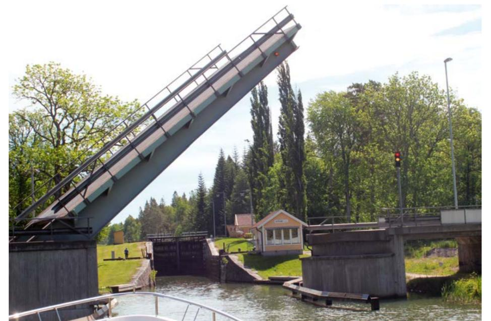
*Один из сотен разводных мостов. Ширина строго 7 метров, как в шлюзе.*
