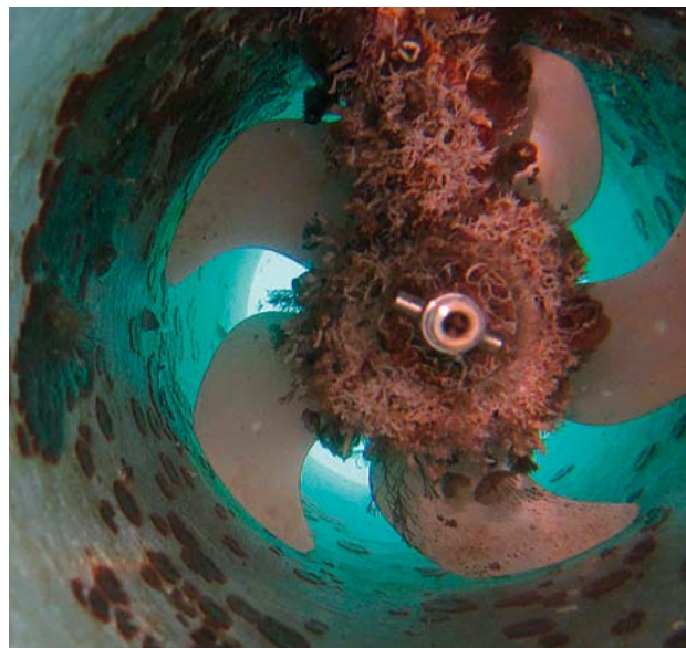
Главный «бич» тоннельной подрулки — густые водоросли и рукотворный мусор вроде полиэтиленовых пакетов. Они тормозят не только поток воды, но и собственно импеллер с электромотором, что может привести к его быстрому перегреву и полному выходу из строя.
