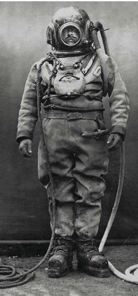
*Хотя с конца позапрошлого века конструкция вентилируемого водолазного скафандра практически не изменилась, она до сих пор продолжает служить верой и правдой — парящим под водой дайверам-аквалангистам по-прежнему не под силу многие рабочие задачи, для решения которых требуется твердо стоять на ногах в свинцовых ботах и трехболтовке.*
